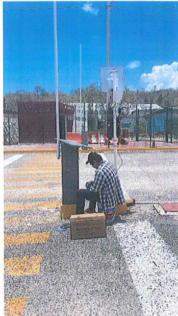
Conexión con Lectora y colocación de fuentes de poder
